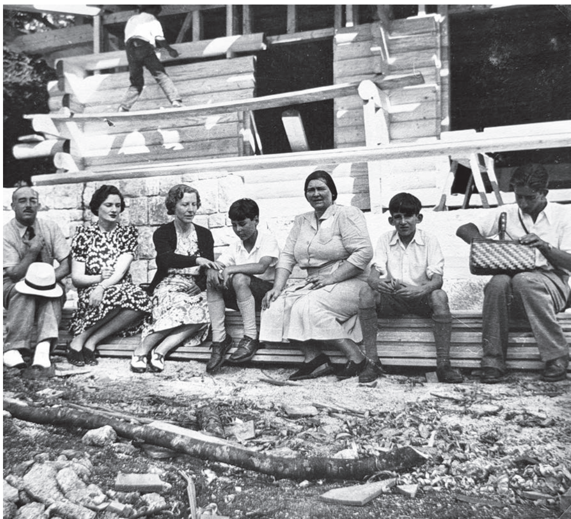
V Andrejevi vasi na Mežakli med gradnjo (Vir: Osebni arhiv Nanija Poljanca.)
