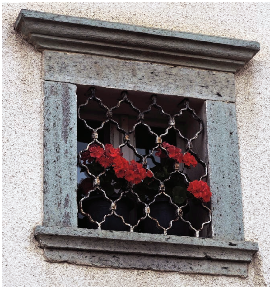
Slika 1: Okenski okvir iz andezitnega tufa v Zgornjih Gorjah (Foto: Matija Zorn)
