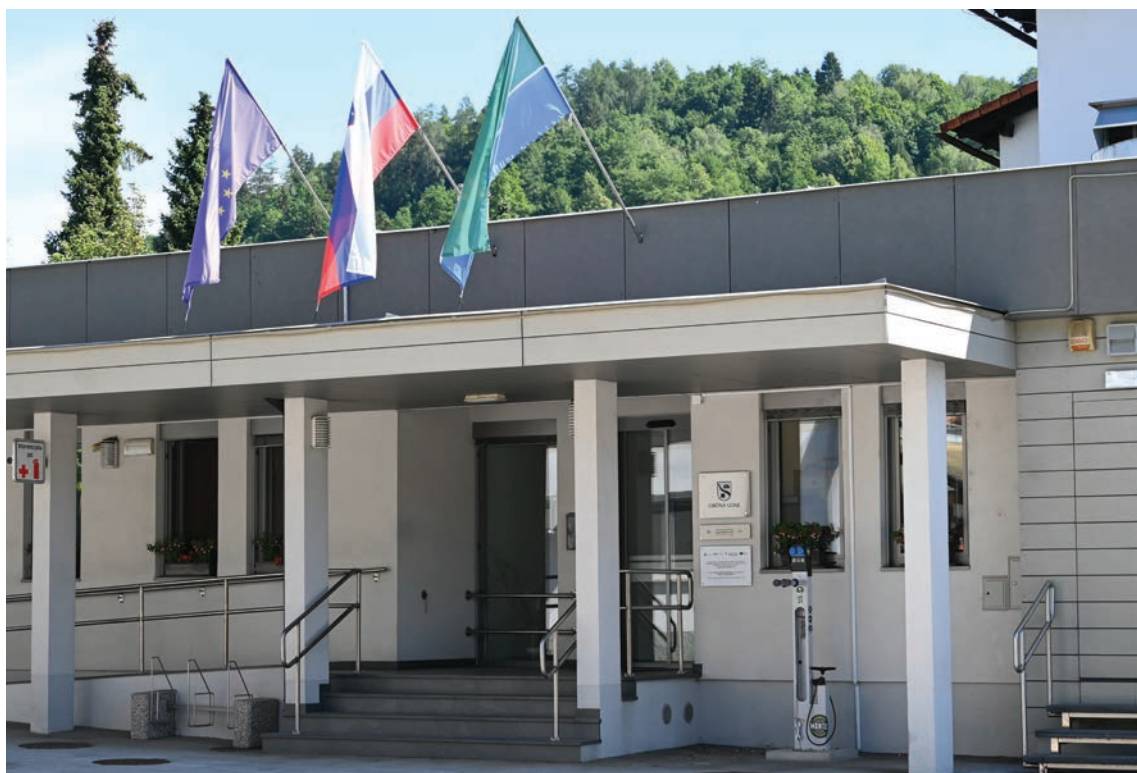
Stavba Občine Gorje, 2026 (Foto: Božidar Flajšman)
